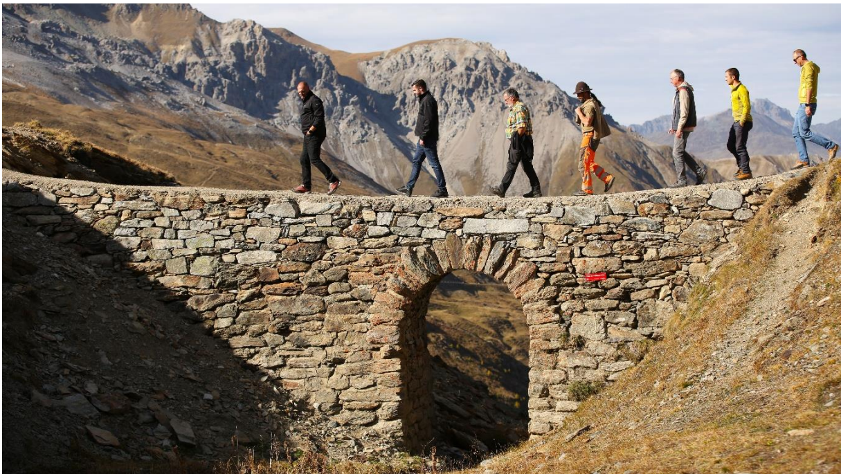
Begehung der sanierten Brücke über den Bach Muranzina mit den Geldgebern, Gemeindevertretern, dem Vorarbeiter, dem Fachexperten und der Projektleitung (Bild: Nicole Matschoss).
