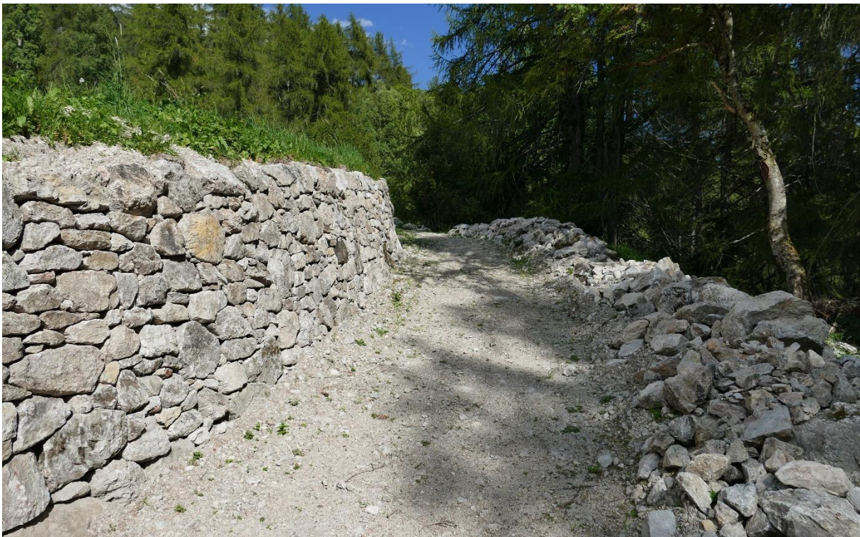
Teilbereich der zweiten Etappe der Instandstellung des historischen Weges zwischen Punt Lü und Lüsai, kurz nach der Bauabnahme (Bild: Yves Schwyzer).
